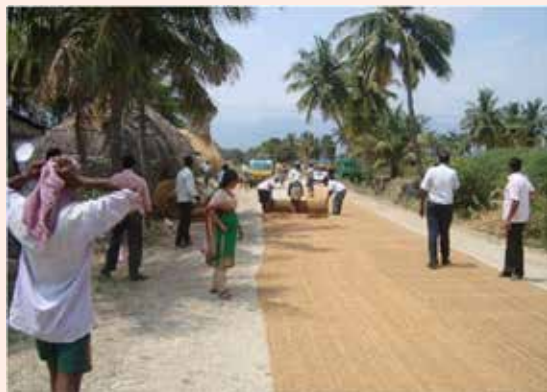
(d) Laying of coir geotextile
